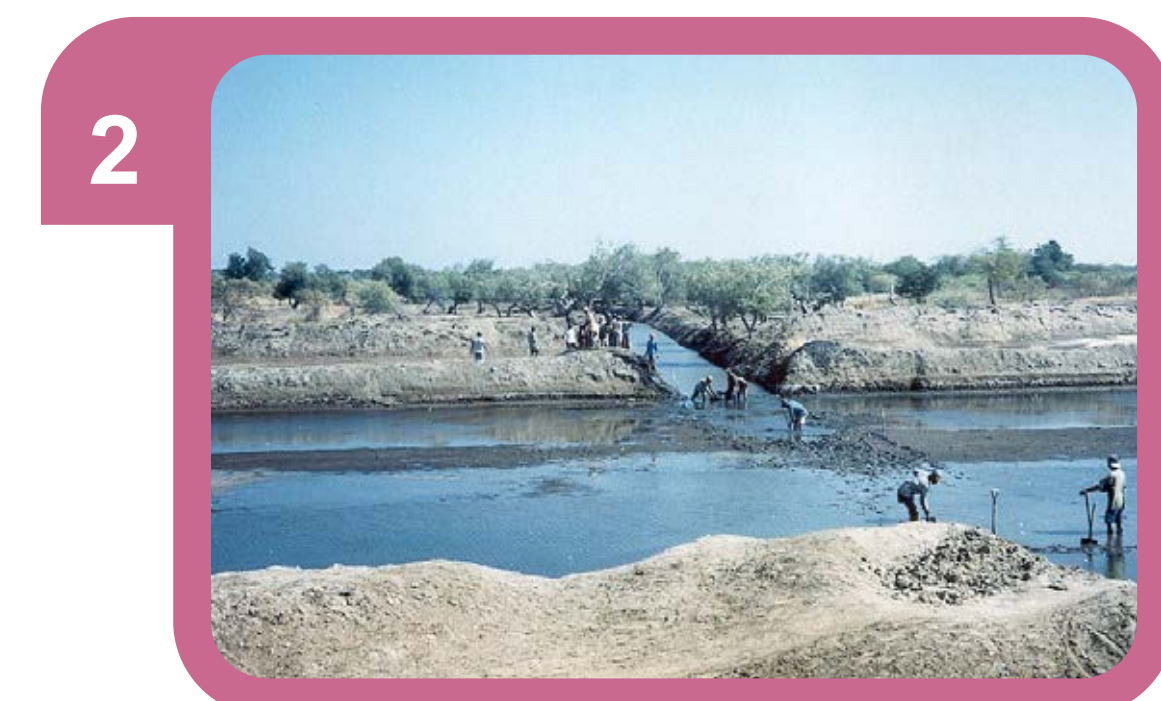
2 Pembuatan saluran dan kolam penampungan/waduk/bozem air laut untuk proses pembuatan garam. Kedalaman Kolam Penampungan 50 cm. Lokasi Desa Waekokak II Kab. Ngada Propinsi NTT.
